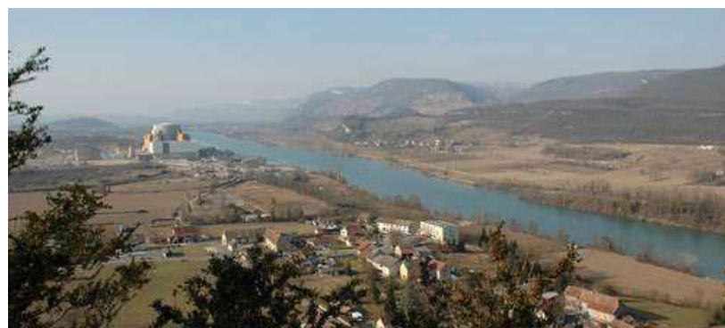
Vue sur la centrale de Crey
